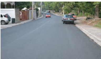
Asfaltado en centros urbanos
